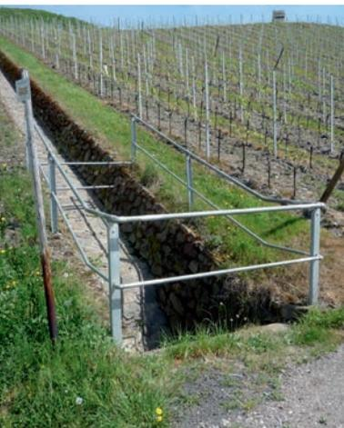
*Geländerhöhe mindestens 1 Meter mit Mittelstange, wenn sich das Gelände an der Absturzkante befindet*
